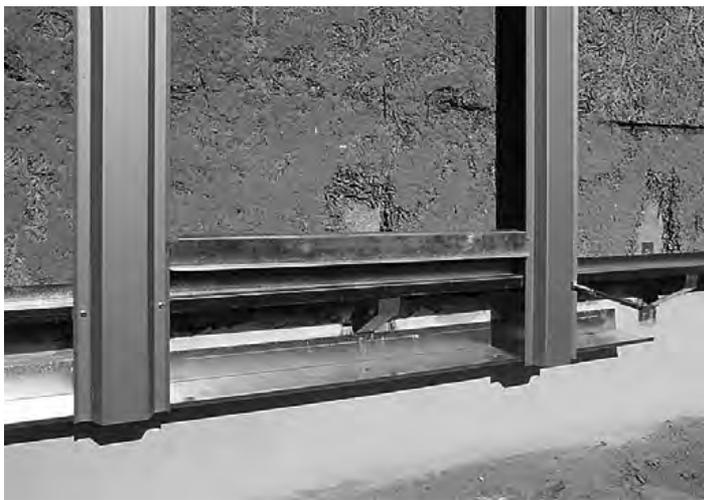
Quando si utilizza il sistema portante DEKMETAL valgono gli stessi principi per le distanze dei profili verticali e degli elementi di ancoraggio - vedere le tabelle Distanze assiali massime degli elementi di ancoraggio nei capitoli 7.1.3.1 Posa dei pannelli CETRIS® VARIO e 7.1.3.2 Posa dei pannelli CETRIS® PLANK.
