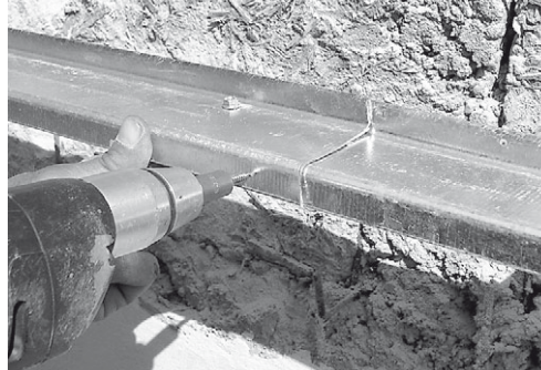
Assemblage des profilés Z50, la grandeur de chevauchement est de 100 mm.
