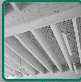
Faux-plafonds et soubassements
