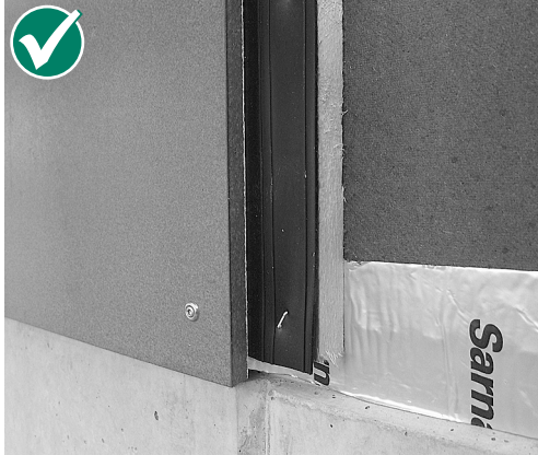
Joint de dilatation – grille en profilés aluminium ou en profilés zingués
